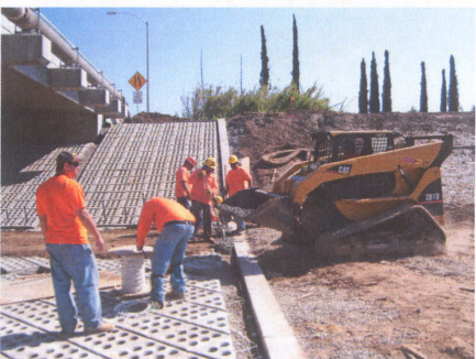
Fig. 28 – Concrete Closure Pour
