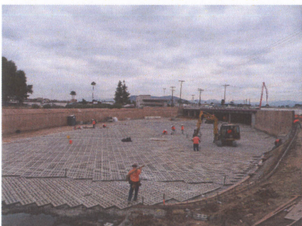
Fig. 20 - Enviroflex ® Installation
