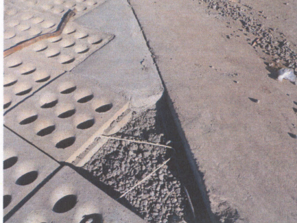
Fig. 25 - Concrete Closure Pour
