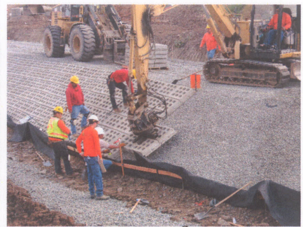
Fig. 19 - Enviroflex ® Installation
