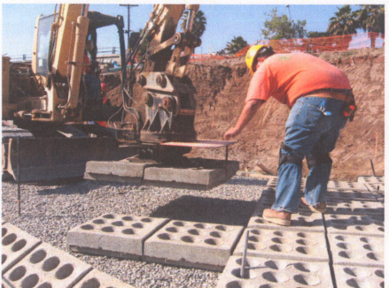
Fig. 21 - Enviroflex ® Installation
