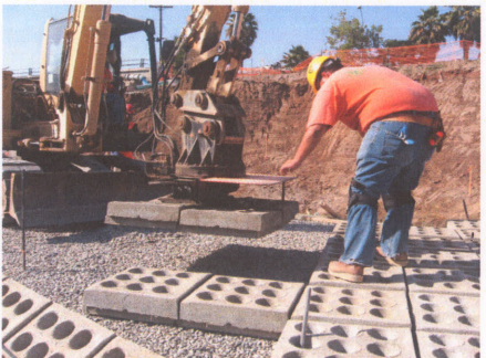
Fig. 21 - Enviroflex ® Installation
