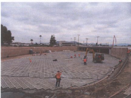
Fig. 20 - Enviroflex ® Installation
