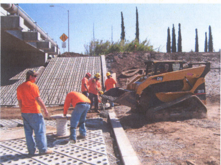
Fig. 28 – Concrete Closure Pour
