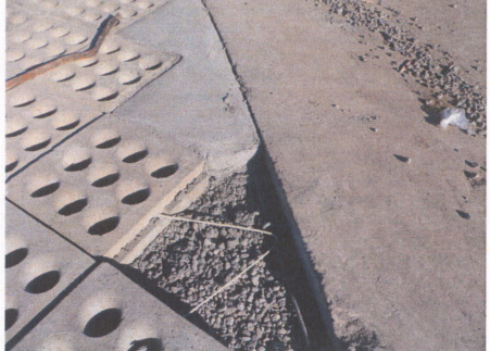
Fig. 25 - Concrete Closure Pour
